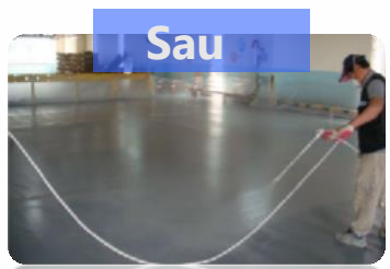
Dùng máy phun khí nén, hạt tạo nhám phân bố đều
