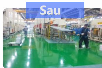
Đóng rắn nhanh, chỉ cần 01 ngày để thi công
